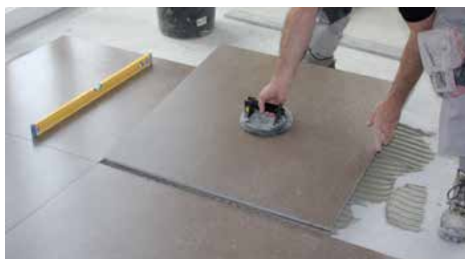
Fig. 12 – Lægning af en porcellanatoflise i format 90 x 90 cm. Hjælpe midler som den her anvendte sugeløftekop letter arbejdet betydeligt.
