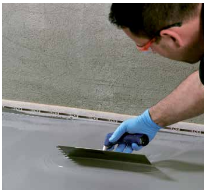
Fig. 4 – Med den let flydende udjævningsmasse PCI Periplan® Extra kan ujævne gulve nivelleres hurtigt og enkelt.
