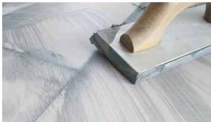
Fig. 4 – Ved efterfugning med gummispartlena opnås en rigtig god udfyldning.
