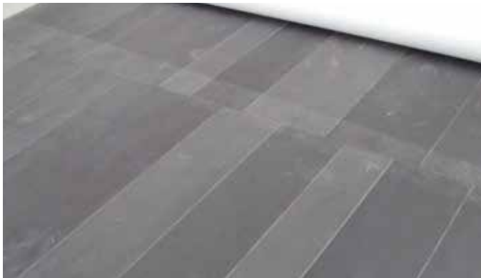
Fig. 10 – Fint støv har forårsaget misfarvning her; afdækningen blev ikke støvsuget, inden den blev fjernet.
