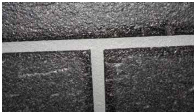
Fig. 9 – Perfekt vasket fuge – næsten i plan.
