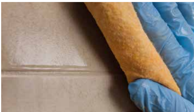
Fig. 6 – Sådanne vandansamlinger skal fjernes med en sugende fiberklud.
