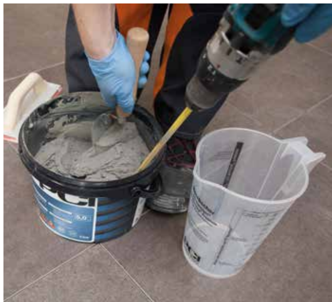
Fig. 3 – Også mørtelpulveret på kanten af spanden skal iblandes omhyggeligt.
