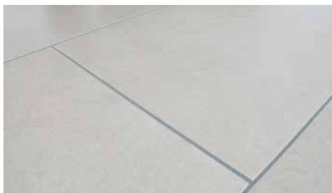
Fig. 8 – Med PCI fugefiber kræves meget lidt vand for at glatte fugemørtlen; lønnen: Ensartede, godt fyldte fuger.
