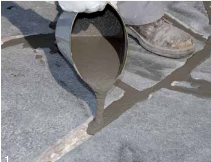
Ifyldning af PCI Pavifix® CEM Rapid i støbevarianten.
