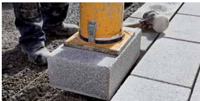
Ombygning i centrum af Augsburg med PCI Carraflott® NT.
