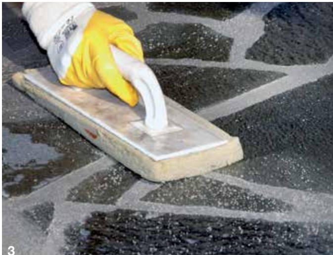
Flisebelægningen rengøres med et svampebræt.
