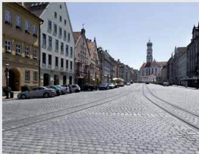
Lavere støjniveau ved fyldte fuger.
