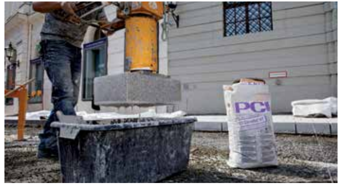
Ombygning i centrum af Augsburg med PCI CarrafloTT® NT.
