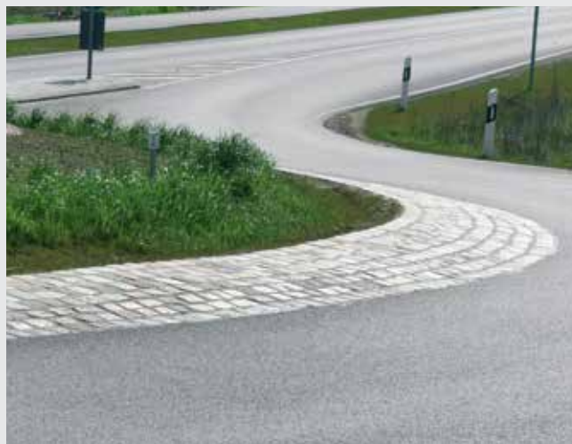
Kraftigt belastede områder som rundkørsler og busbaner vil ofte kun kunne holde i en bundet konstruktion.
