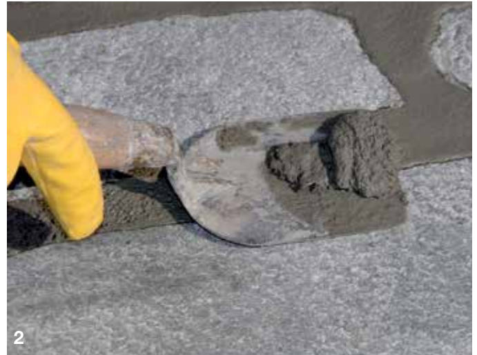
2 Afskæring, når materialet begynder at stivne (afprøves med en fingerspids).
