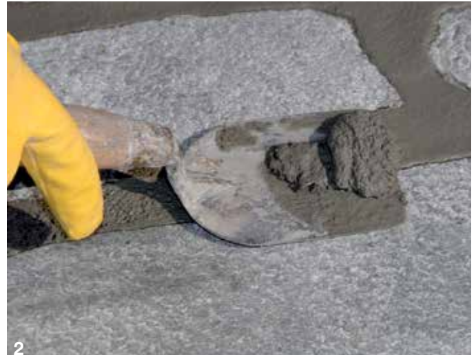
Afskæring, når materialet begynder at stivne (afprøves med en fingerspids).
