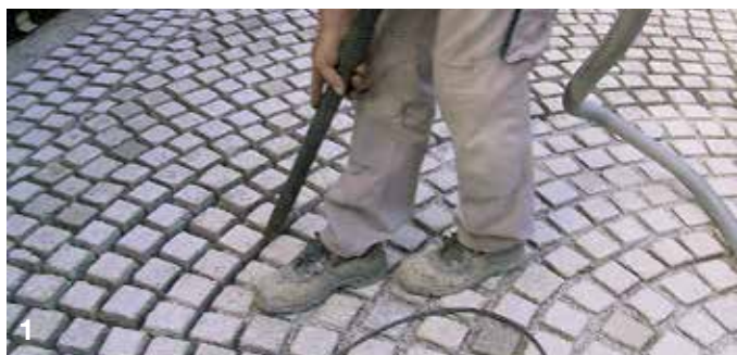
1 Opsugning af sættematerialet for at opnå den nødvendige fugedybde.
