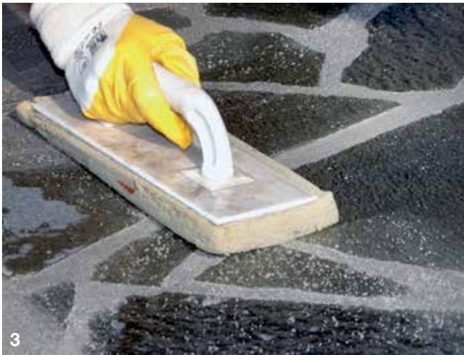
3 Flisebelægningen rengøres med et svampebræt.
