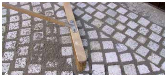
Med en blød kost fejes det overskydende materiale af, og der dannes en homogen overflade.
