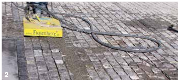
2 Til større flader kan en såkaldt "Fugenhexe" anvendes.
