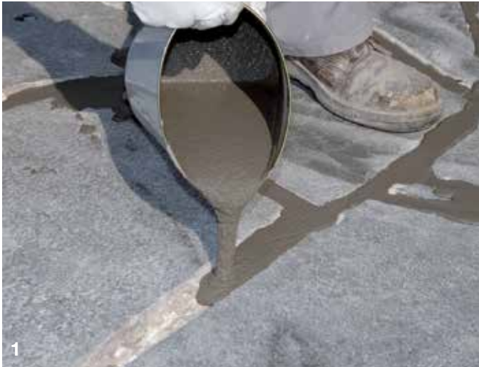
1 Ifyldning af PCI Pavifix® CEM Rapid i støbevarianten.
