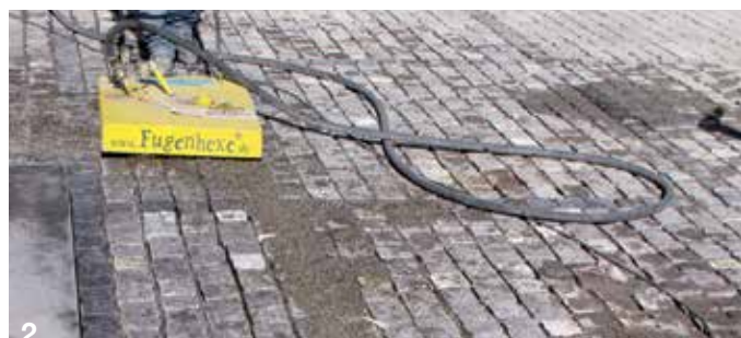
Til større flader kan en såkaldt "Fugenhexe" anvendes.
