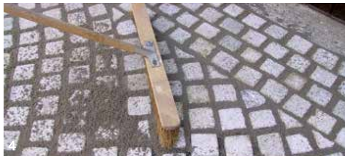
4 Med en blød kost fejes det overskydende materiale af, og der dannes en homogen overflade.
