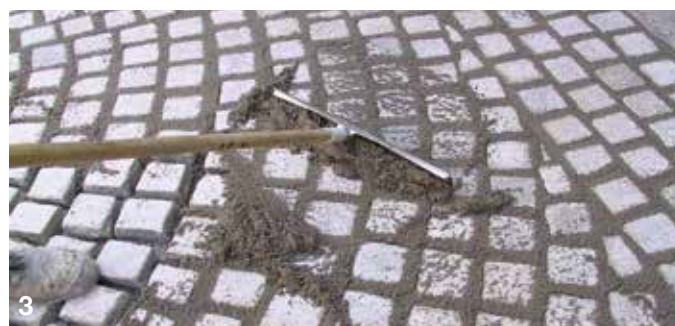
Indarbejdning og komprimering af fugematerialet PCI Pavifix® 1K Extra med en gummiskrabber.
