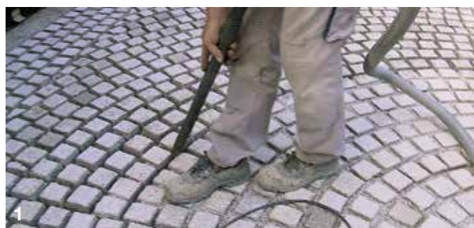
Opsugning af sættematerialet for at opnå den nødvendige fugedybde.
