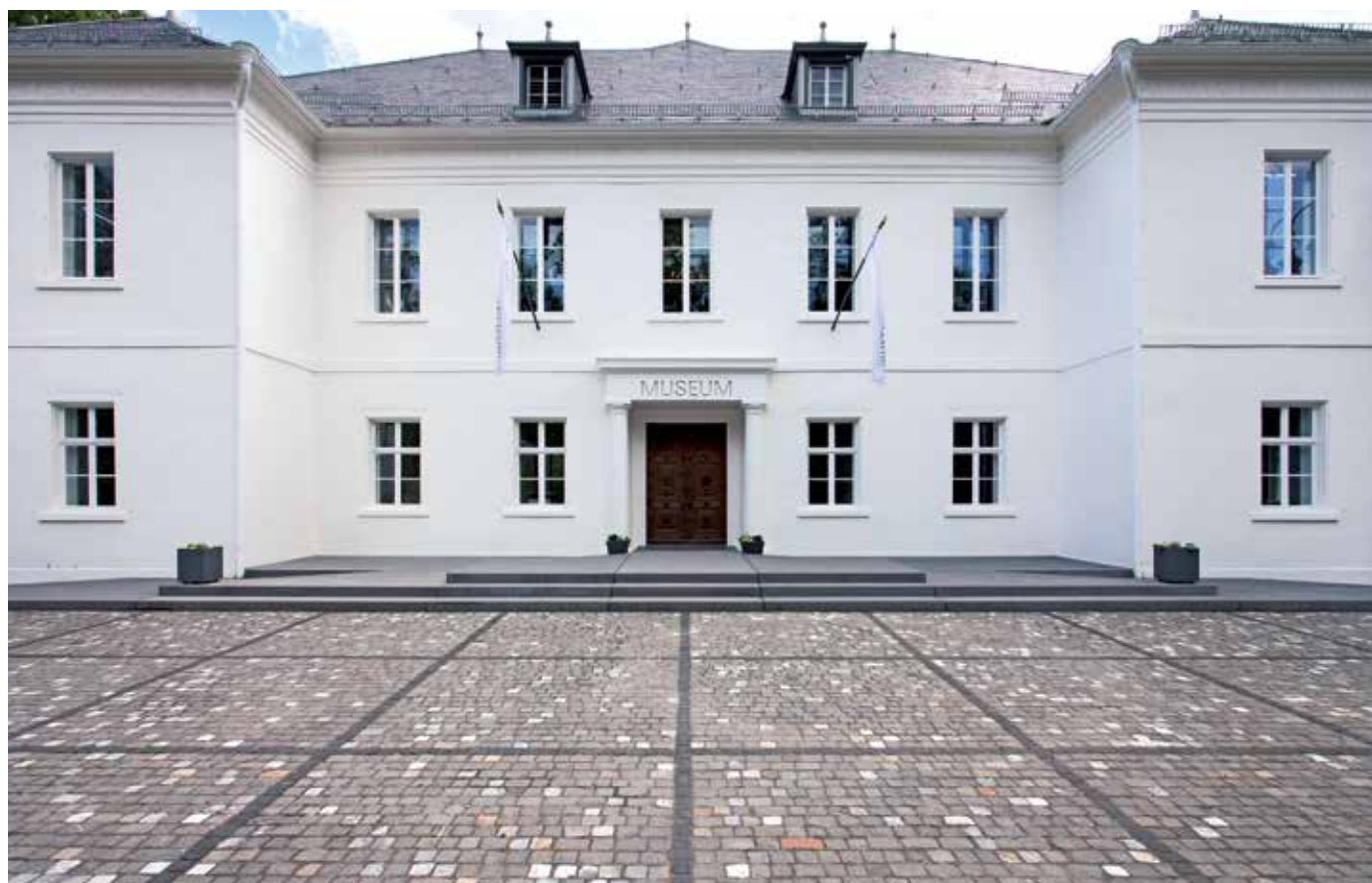
Biedermann-museet i Donaueschingen, fuget med PCI Pavifix® PU.
