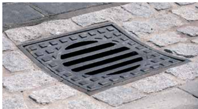
Undtagelsen i DIN 18318, afløbsrende fuget med PCI Pavifix® CEM.
