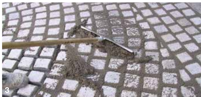
3 Indarbejdning og komprimering af fugematerialet PCI Pavifix® 1K Extra med en gummiskraber.
