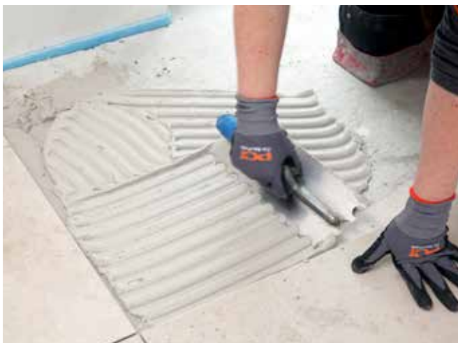
Lægning af naturstens fliser på vandtætningen
