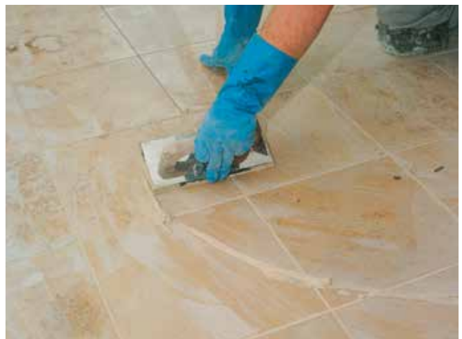
Fugning med hurtig afbindende mørtelfuge
