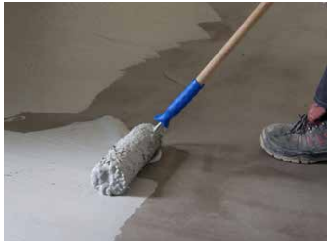
Vandtætning af gulvet
