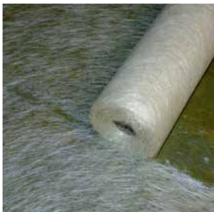
PCI Fibermätte GFM rulles ud på det primede underlag.
