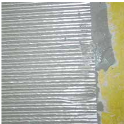
Den lagte PCI Forstærkningsmätte GFS efter fjernelse af beskyttelsesfolien.
