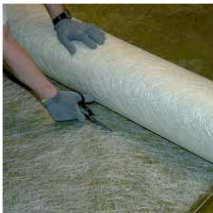
Tilskæring af PCI Fibermätte GFM med saks.
