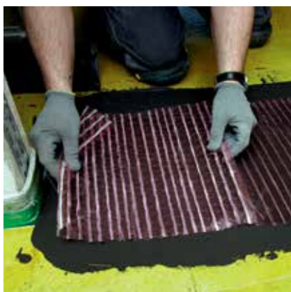
PCI Forstærkningsmätte GFS lægges i den friske udjævningsmasse.
