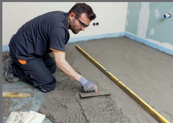
Yderligere glitning af overfladen er ikke nødvendig efter afretning og bearbejdning med pudsebræt.
