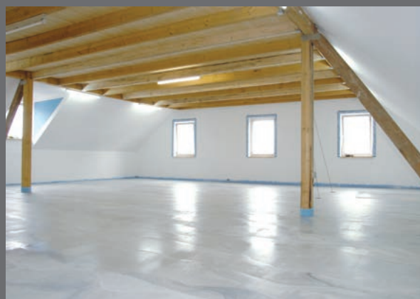
På grund af den lave egenvægt forløber byggeriet hurtigt og uhindret, selv ved mindre stabile underlag.
