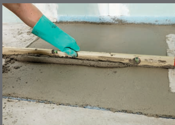
PCI Novoment® Light tillader lagtykkelser fra 20 til 80 mm og er fugtbestandig – ideel til brug i permanent fugtige områder og på underlag med fald.
